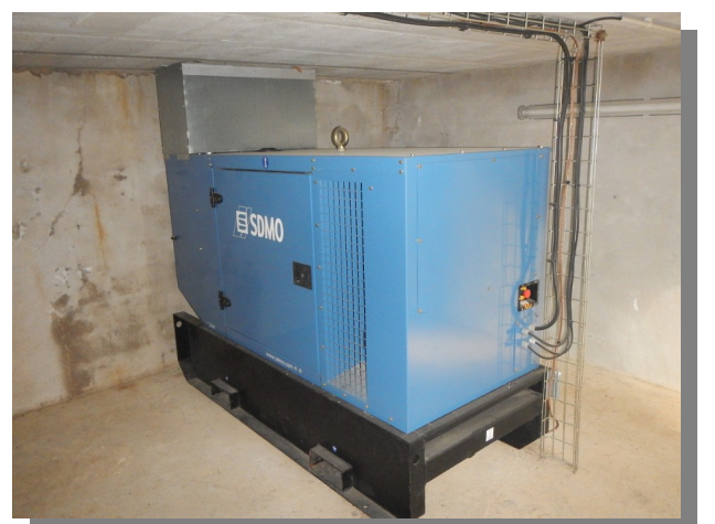
Groupe électrogène de secours
