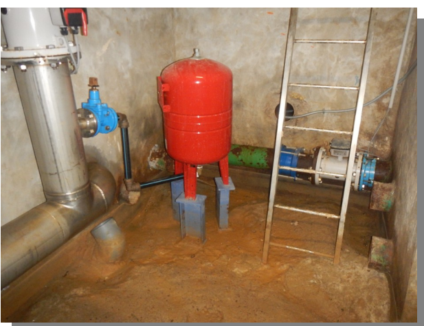
Ballon anti-bélier et débitmètre sur distribution gravitaire
