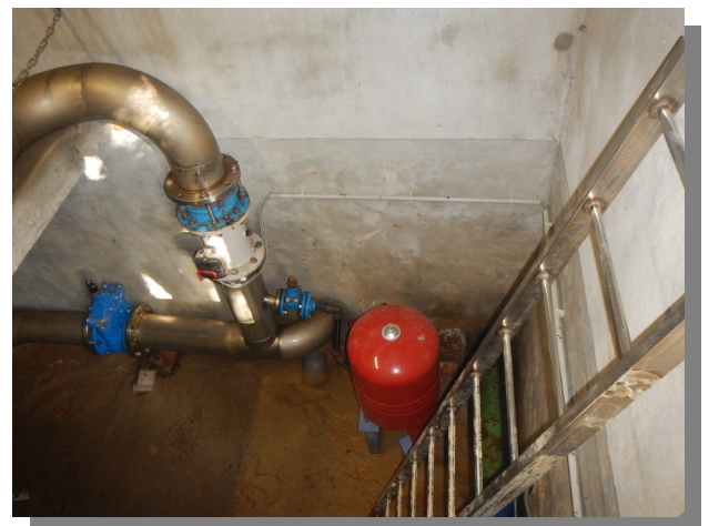
Débitmètre sur conduite surpressée
